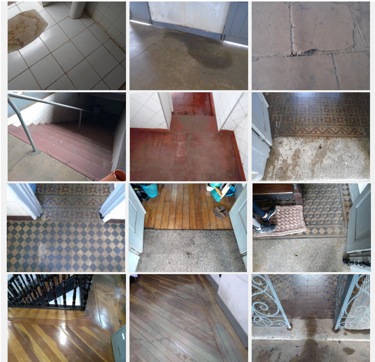
Fig. 7: Detalhes de Pisos e Escada
