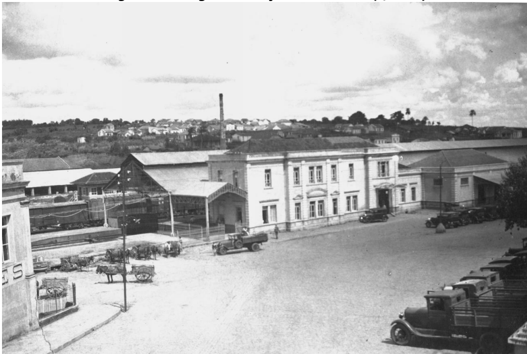
Figura 20: Largo da Estação Ferroviária (s/data)
