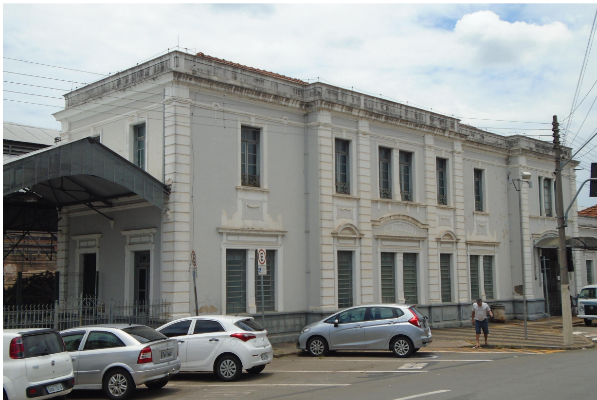
Fig. 2: Vista da Estação Ferroviária
