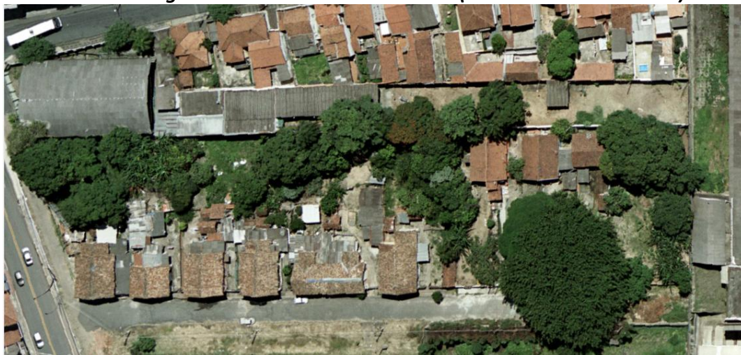
Fig. 12: Vistas da Vila Ferroviária (datas não coincidentes)
