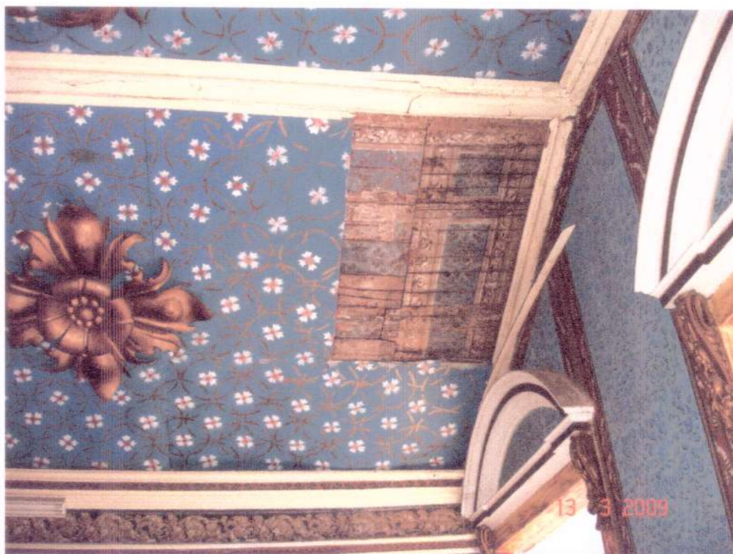
Fonte: J. Binotti, 2008. – Forro original da nave encontrado sob o forro existente.
