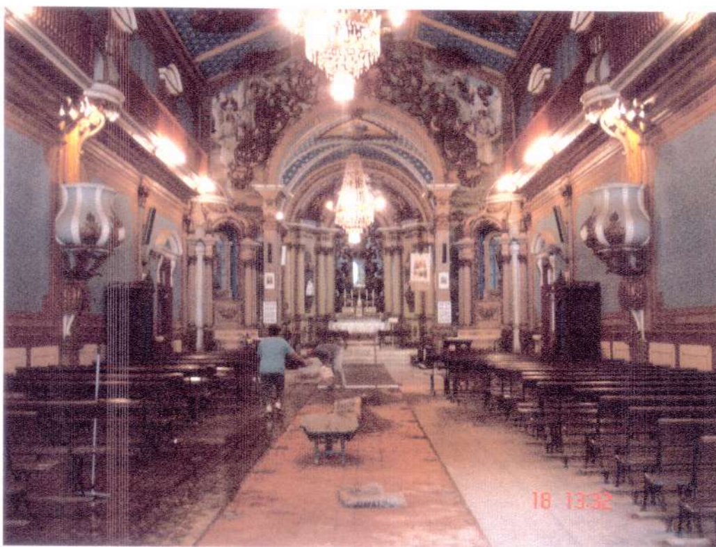
Fonte: J. Binotti, 2007. – Reforma do piso da nave.
