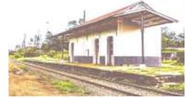
por uma escada, característica que não acontece na estação de Limeira. Outro item que a diferença é a gare, que também encontra-se engastada na alvenaria, porém tem a função de cobertura para a plataforma. No seu interior há a presença de ladrilhos hidráulicos e piso de madeira.
