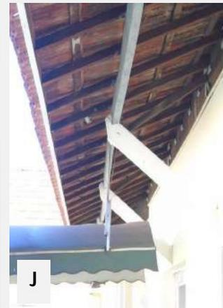
**G:** Detalhe do piso cerâmico vermelho original em bom estado, mantido pela reforma realizada em 2009; **H:** Circulação de saída para salas de aula no Bloco 1 com forro em madeira original e piso cerâmico branco com pequeno recorte mantendo o piso cerâmico vermelho original; **I:** Escada em cerâmica vermelha original na saída do Bloco 1 para o pátio coberto; **J:** detalhe da mão francesa do beiral do Bloco 2.
