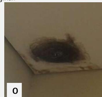
**M:** trecho externo da parede do refeitório com descolamento do revestimento cerâmico original; **N:** entrada administrativa da creche; **O:** trecho do forro de gesso com infiltração.
