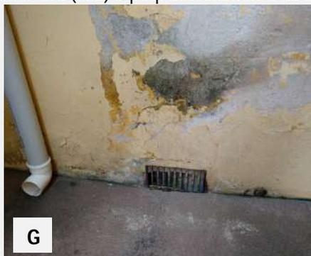
**F:** vista da lateral da creche na divisa com o Shopping Pátio, que apresenta instalações hidráulicas expostas, à direita, parte do bloco 4; **G:** infiltração no bloco 2
