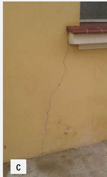
**A:** Parte da fachada frontal da Creche (blocos 1 - pav. Térreo - e 5 - pav. Superior); **B:** pergolado que interliga os bloco 1 e 3 na fachada da Av. Pref. Alberto Ferreira; **C:** pequena trinca no bloco 1.
