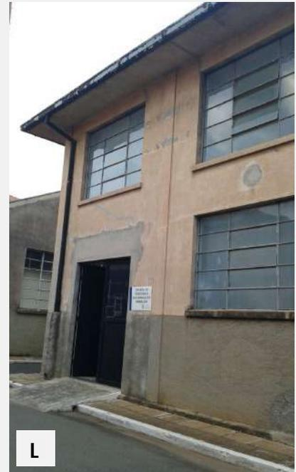
**J:** Trecho sem cobertura de telhas devido à paralisação da obra em 2013 (bloco 5); **K e L:** Recomposição parcial do revestimento em argamassa de cimento e areia, não respeitando o tipo existente de revestimento do tipo 'argamassa raspada'.
