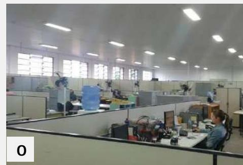
**M:** Auditório no pav. térreo do Bloco 4; **N:** Corredor de acesso ao DGS e SEURB, com piso em taco de madeira desgastado; **O:** SEURB no Bloco2-pav. sup., com piso em concreto desempenado, forro em PVC e divisórias
