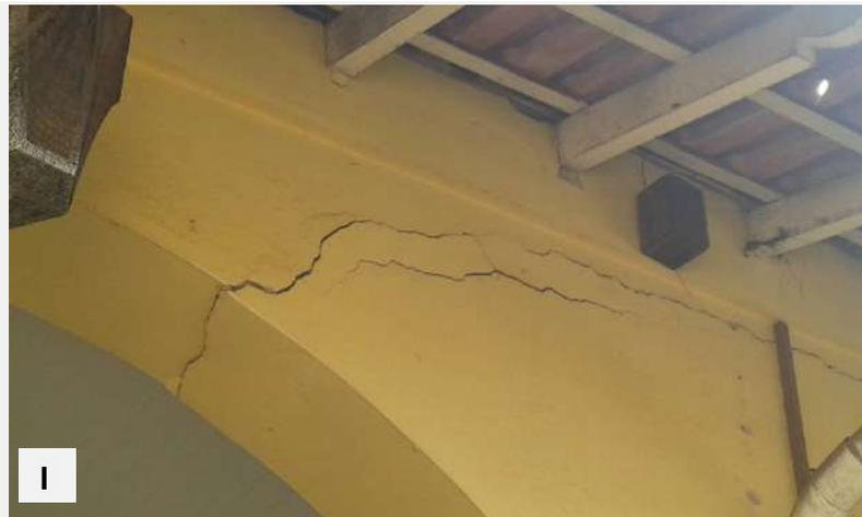
**H e I:** pontos que apresentam trincas de recalques da fundação no bloco 3.
