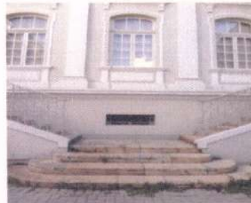
Foto 19 – Detalhe da escadaria.
