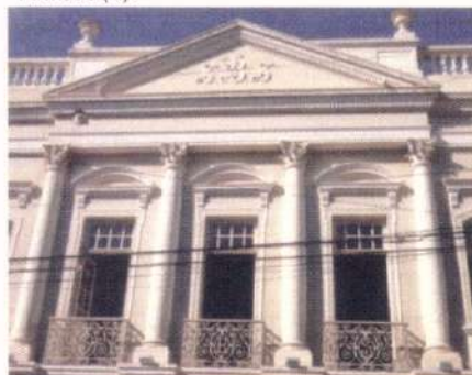
Foto 06 – Ano, 2014. Acervo P.M.L. Detalhamento da Fachada (B) da Rua Boa Morte.
