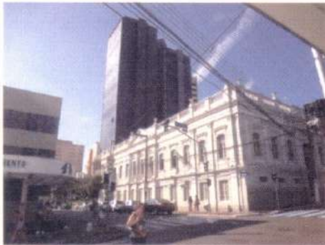
Foto 03 – Ano, 2014. Acervo P.M.L. Vista da esquina das Ruas Boa Morte com Alferes Franco.
