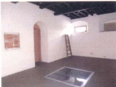
Foto 20 – Interior do Pavimento inferior – antiga Senzala. Na janela de piso, envidraçada, estão à Mostra as pedras do piso original.
