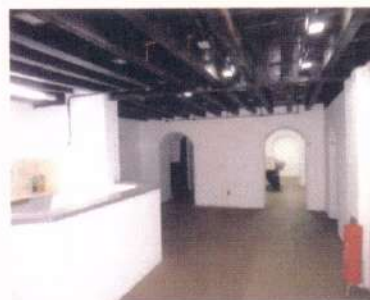
Foto 21 – Detalhe do barroteamento do piso superior no pavimento inferior.
